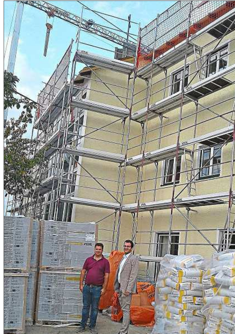
Architekt Martin Maier (l.) informiert Bürgermeister Florian Gams auf der Baustelle an der Grundschule in Sandbach – Foto: Ho
